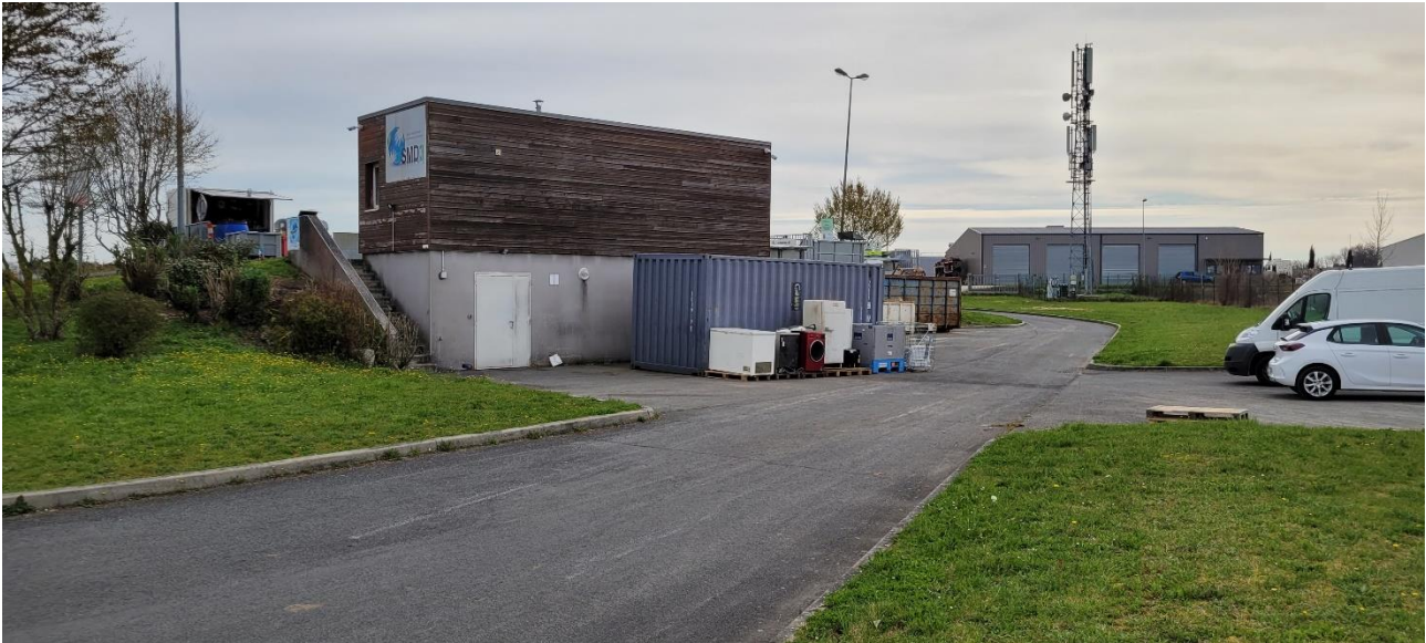
Figure 12 : Prise de vue 7 - Depuis le bas de quai en direction de la zone de dépose des DEEE (photographie prise le 22/03/2023)
