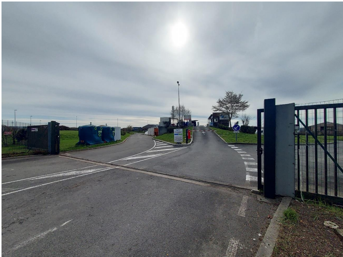
Figure 6 : Prise de vue 1 - Depuis l'entrée existante de la déchèterie (photographie prise le 22/03/2023)
