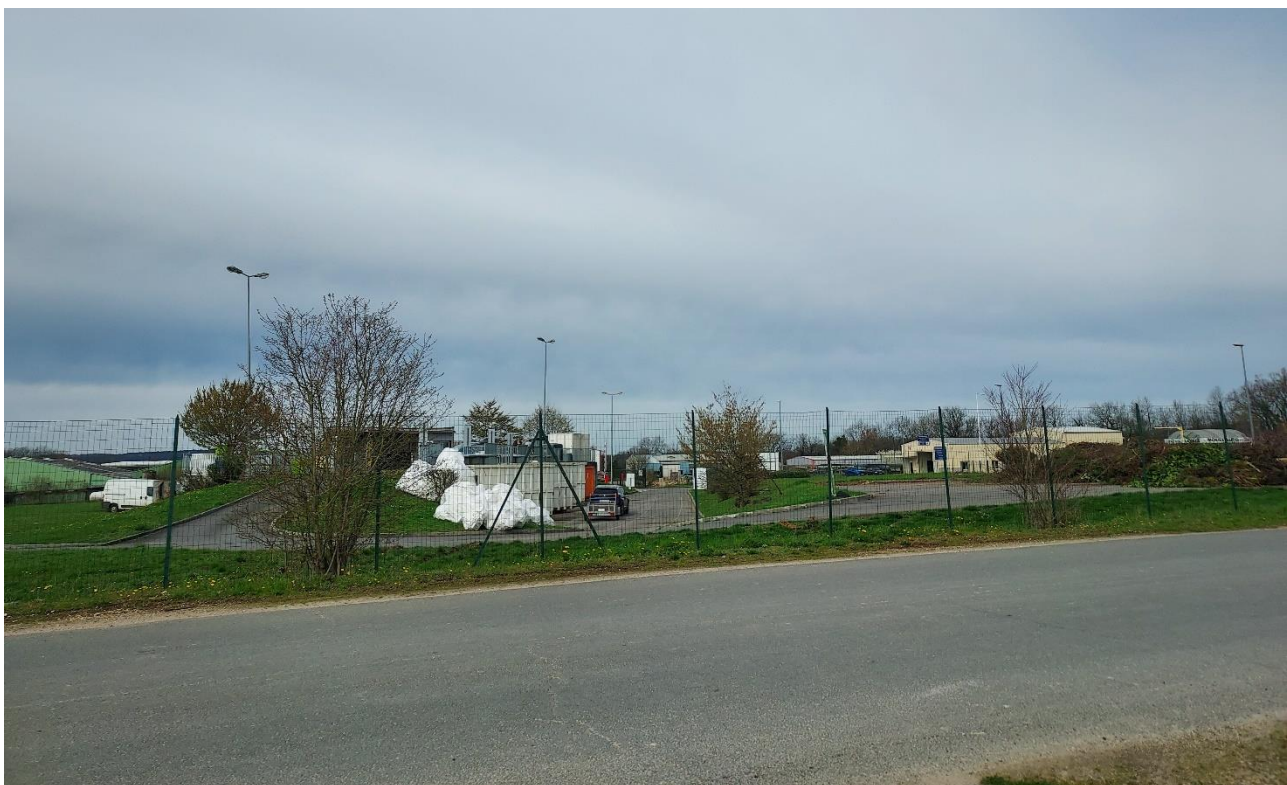
Figure 19 : Prise de vue 14 – Depuis l'Est de la déchèterie (photographie prise le 22/03/2023)
